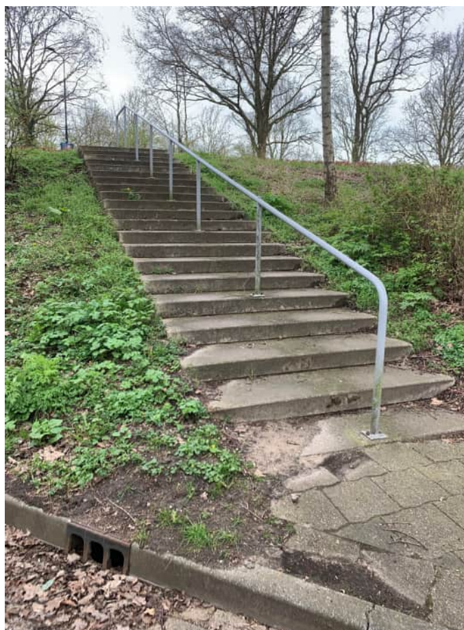
Huidige trap vanaf talud viaduct naar Willestee
