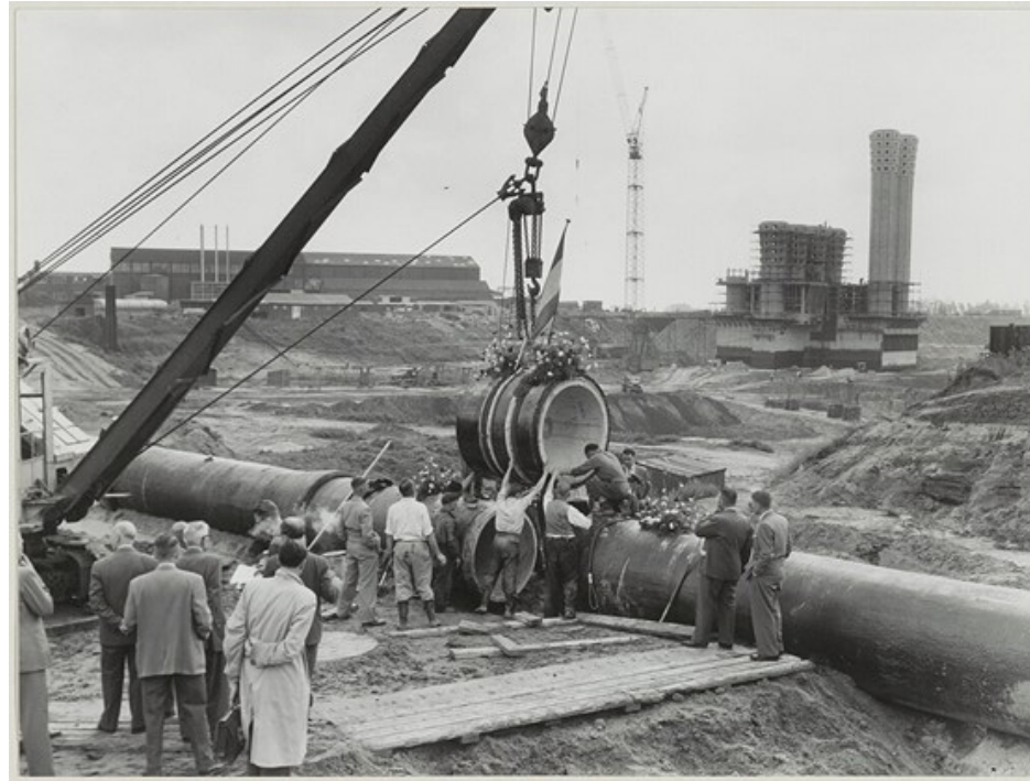
De plaatsing van het laatste stuk van de buisleiding IN 1957 bij het Noordzeekanaal.
