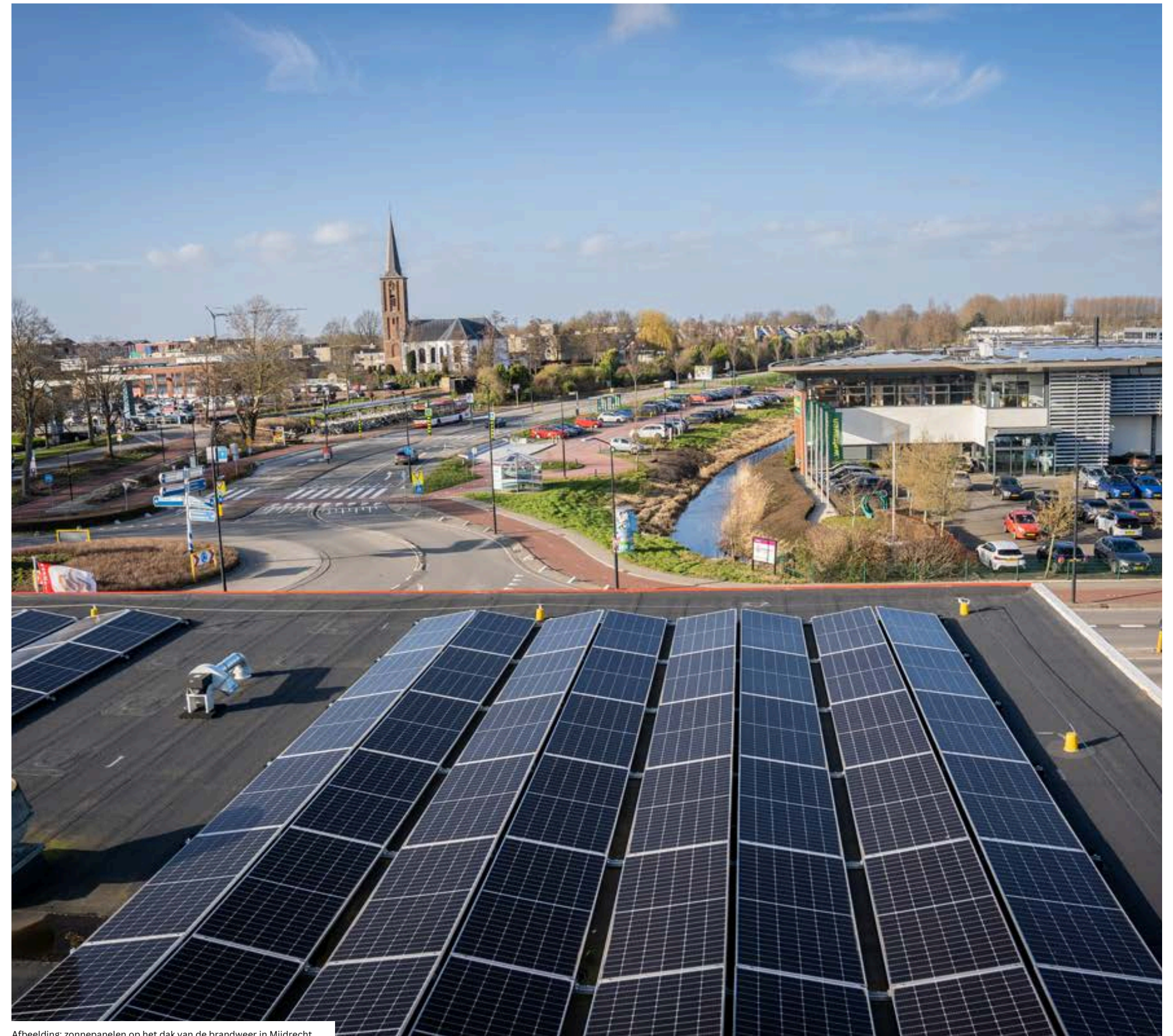
Afbeelding: zonnepanelen op het dak van de brandweer in Mijdrecht
